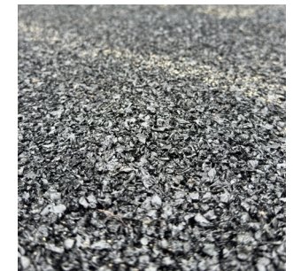
Wet Pour Surfacing
